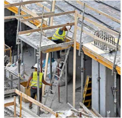
Un cantiere edile
